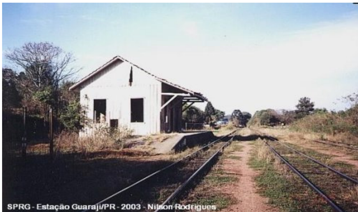
Fotografia 05 – Estação Ferroviária de Guaragi – 2003 – Autor: Nilson Rodrigues Fonte: http://www.estacoesferroviarias.com.br/pr-tronco/guaragi.htm Acesso: 28/04/2013
