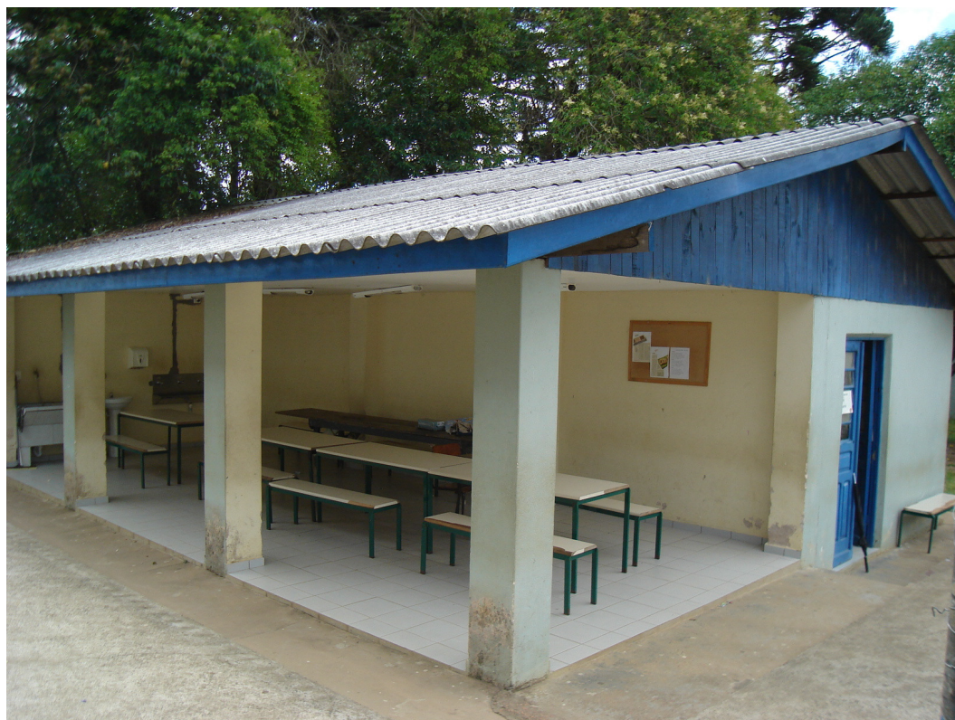
Fotografia 14 – Guaragi: CE Munhoz da Rocha – refeitório e sala da comunidade. Atualmente (2012) utilizada como sala de aula devido a reforma Autora: GRILO, R.B. (2011)
