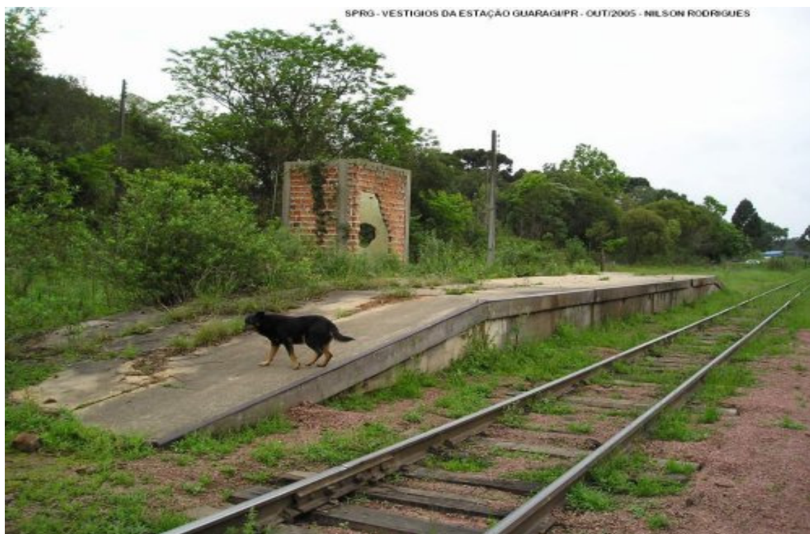
Fotografia 06 – Estação Ferroviária de Guaragi – 2005 – Autor: Nilson Rodrigues Fonte: http://www.estacoesferroviarias.com.br/pr-tronco/guaragi.htm Acesso: 28/04/2013
