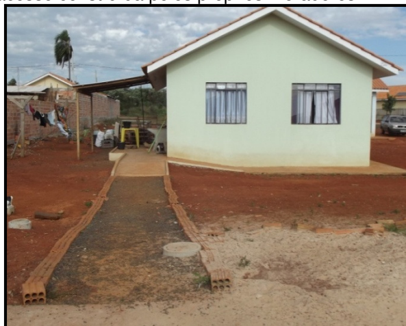
Foto 20 - Casa adaptada do Jardim Recanto Verde em Ponta Grossa-PR com rampa de acesso construída pelos próprios moradores
