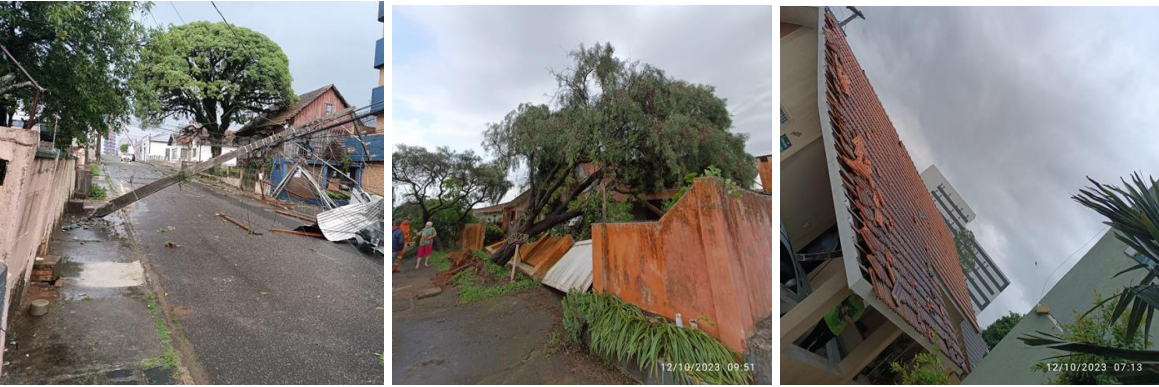
Figura 81 - Danos registrados em 12 de outubro de 2023, Ponta Grossa/PR
