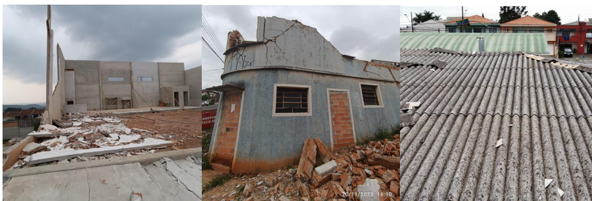
Figura 92 - Danos registrados em 18 de novembro de 2023, Ponta Grossa/PR
