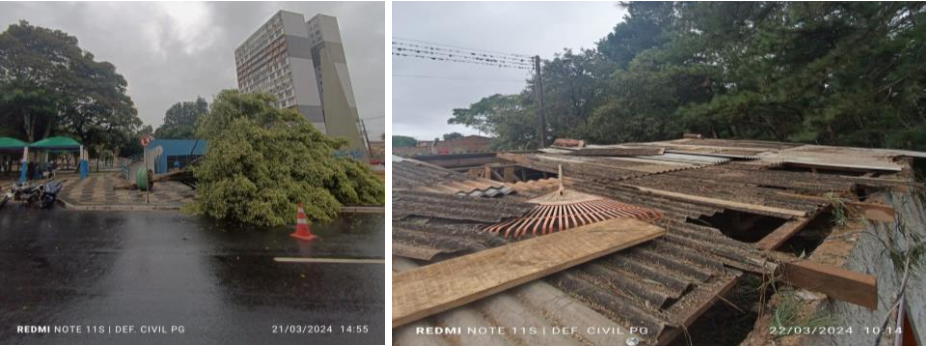
Figura 111 - Danos registrados em 21/03/2024, Ponta Grossa/PR
