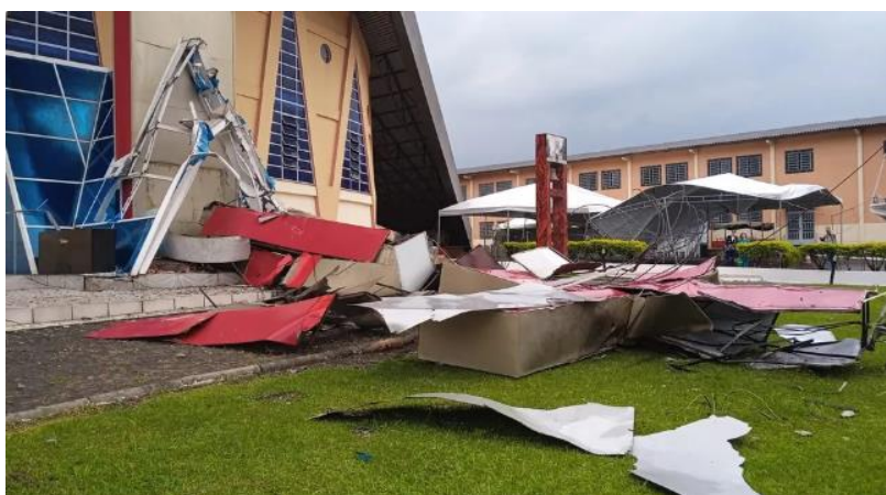
Figura 80 - Danos registrados em 12 de outubro de 2023, Ponta Grossa/PR
