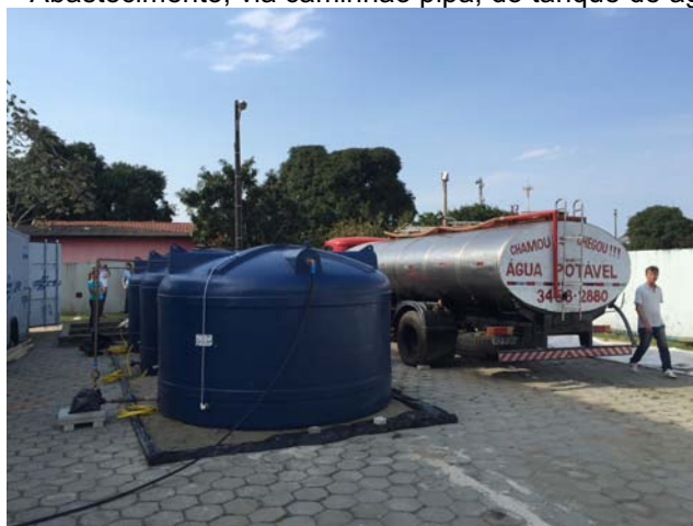
Figura 4.4 – Abastecimento, via caminhão pipa, do tanque de água do mar.
