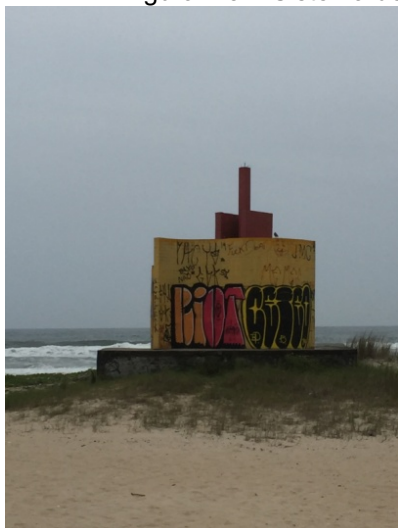
Local onde estão as bombas
