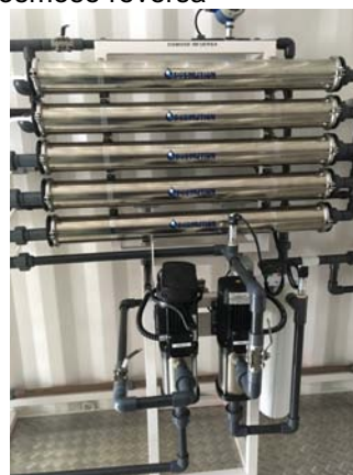
Bombas de OR e lavagem e membranas de OR
