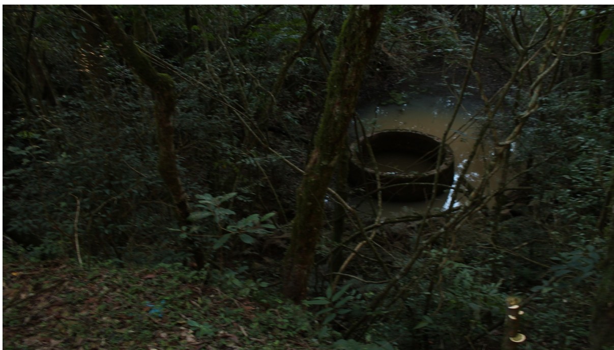
Figura 4: O poço escuro onde se alojaria a turbina da Usina Hidrelétrica do Chopim, 20 metros de escavação ao fim do valetão, há 100 metros do rio.
