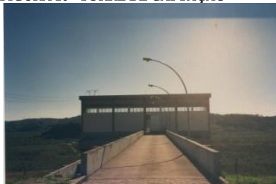
FIGURA 26 - TORRE DE CAPTAÇÃO
