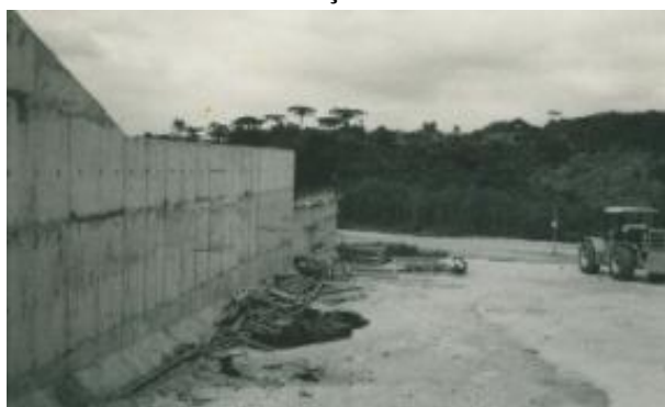
FIGURA 27 - CONSTRUÇÃO DA BARRAGEM
