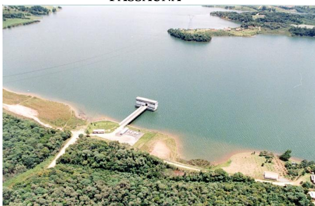
FIGURA 31 - VISTA AÉREA DO RESERVATÓRIO PASSAÚNA
