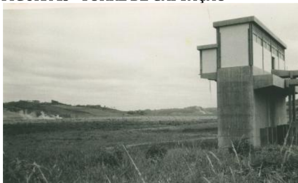
FIGURA 25 - TORRE DE CAPTAÇÃO
