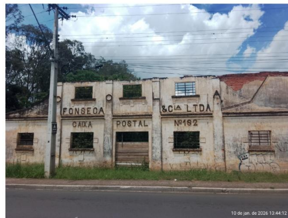
N - Ruínas na Estr. Mun. Sebastião Bastos
