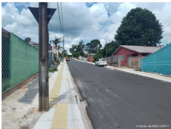
Q - Pavimento e calçamento na R. Maria Aparecida Veiga Gomes
