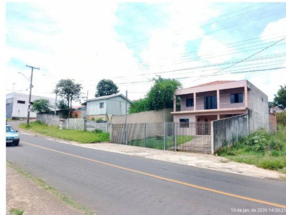
U - Edificações Residenciais na R. Neci Nunes Ferreira
