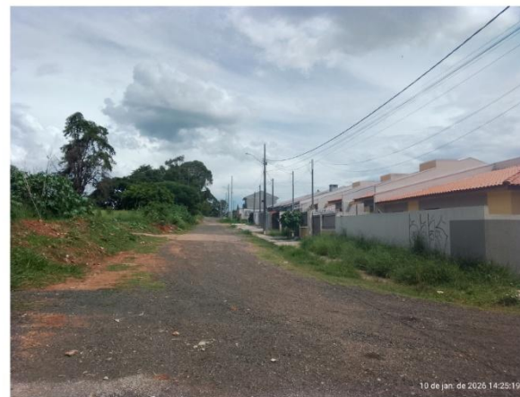
W - Pavimento tipo Pedrisco na R. Boleslau Brigola e Faixa de Domínio da rede Ferroviária
