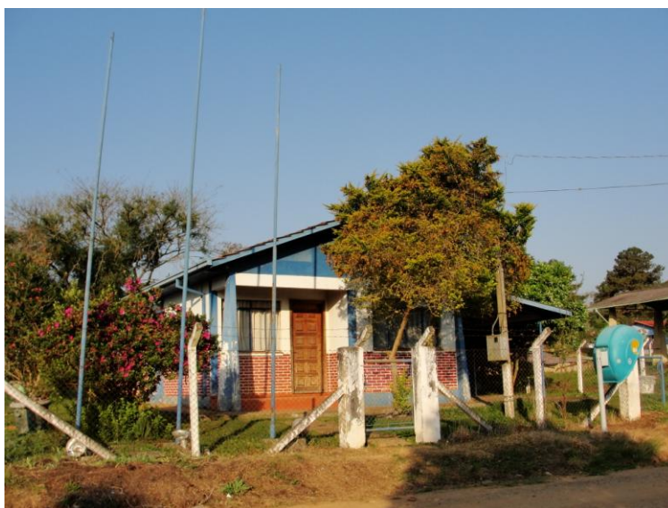
Figura 27 – Guaragi: Sub-prefeitura – desativada, hoje funciona a sede da Associação dos Moradores Autora: BARRETO, V.M. (2010).
