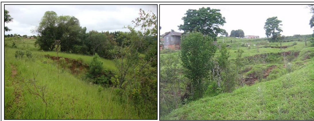
FIGURA 19 – Principais cabeceiras do canal C1. Fotografia da esquerda (29/01/2010) apresenta uma cabeceira menor. Fotografia da direita (08/11/2008 Fonte: MALUF, 2008) apresenta a cabeceira mais relevante deste canal com as paredes laterais cobertas por vegetação.
