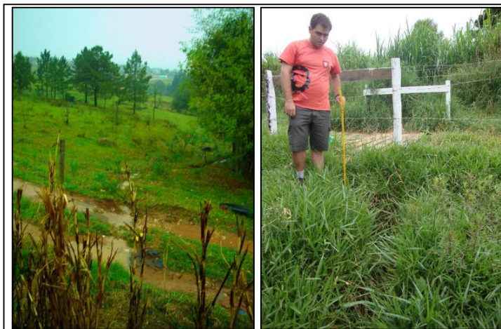
FIGURA 20 – Local em que é despejada a água pelas manilhas que captam água no cruzamento da Rua Rio Araguaia e Rua Isabel Ossoviscki/Rio Amazonas. Esquerda, fotografia obtida em setembro de 2009, havia um sulco de erosão pouco profundo, direita, fotografia de janeiro de 2010, houve necessidade de construção de uma pequena ponte sobre a erosão.
