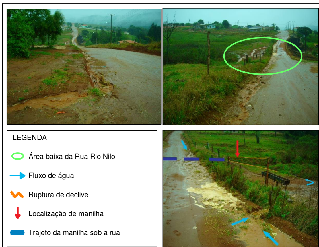
FIGURA 26 – Escoamento superficial pela Rua Rio Nilo. Na primeira imagem, à esquerda é possível observar a topografia da rua, a água converge para a área mais baixa. Em destaque na fotografia superior direita, a área em que a água se acumula adentrando a manilha para passar sob a rua. Na fotografia inferior, observa-se o trajeto do fluxo da água em direção à manilha. (03/09/2009)
