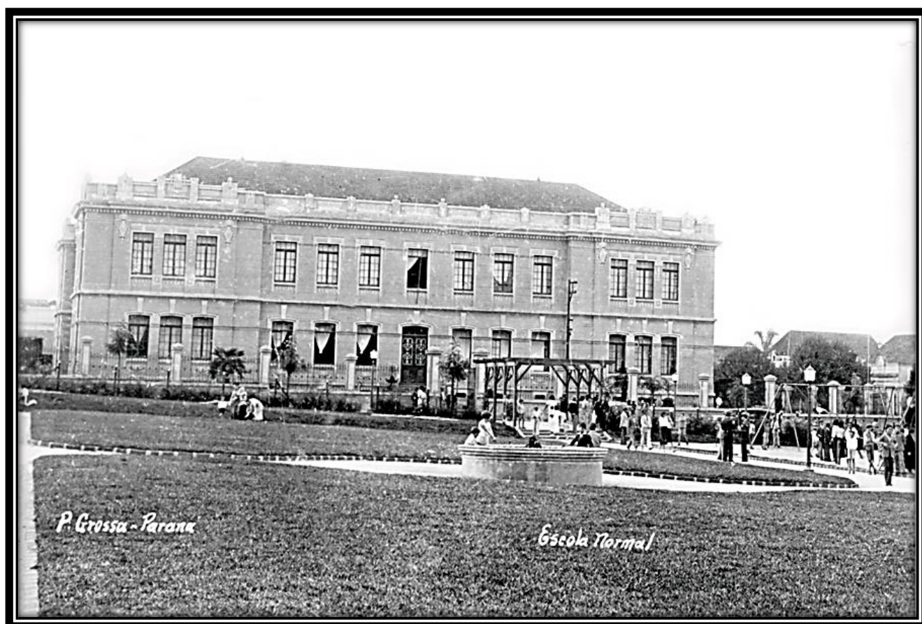
Foto 16. Fotografia da década de 1930, que demonstra a proximidade entre o Colégio Regente Feijó e a praça Barão do Rio Branco. Nessa ocasião a praça ainda não possuía árvores e o parque infantil era recém-construído. (Acervo de Denise Metynoski)
