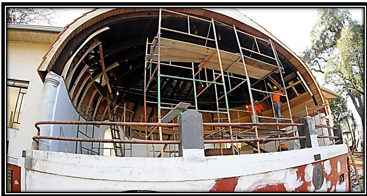
Foto 4. Etapa de reforma da Concha Acústica, onde foi refeito o forro de madeira, a pintura e reparação de danos, em 2015. ( Acervo Prefeitura Municipal de Ponta Grossa)
