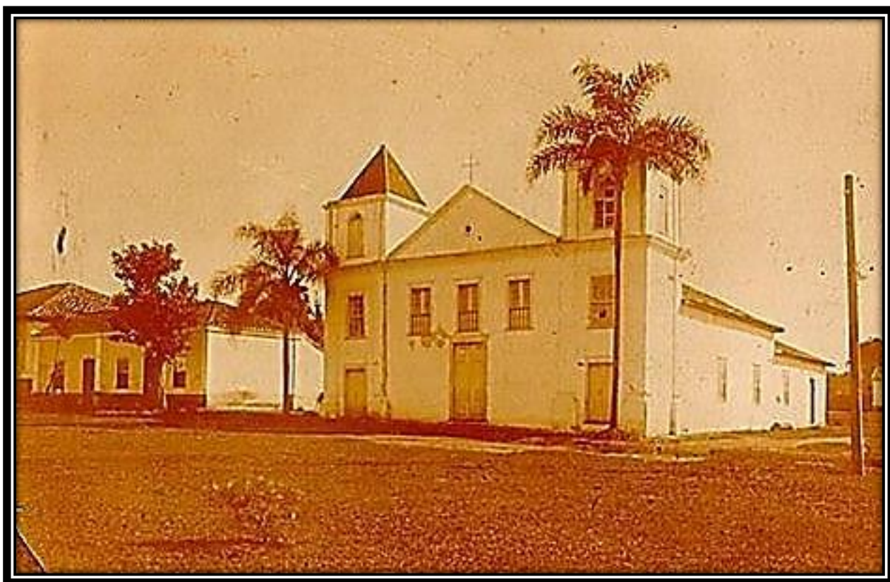
Foto 20. Imagem da antiga Capela do Rosário no começo do século XX, quando haviam começado as instalações de energia elétrica nas ruas do centro da cidade . (Acervo Paulo José da Costa)
