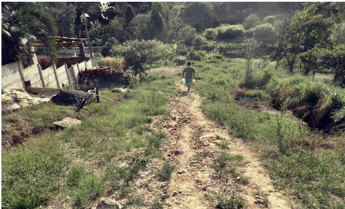
Figura 49 – Falta de manutenção das ruas
