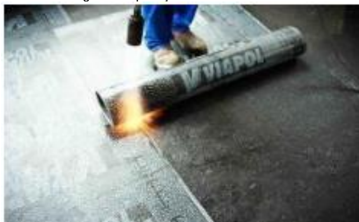
Figura 8: Aplicação de manta asfáltica
