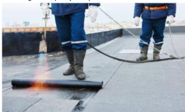
Figura 6: Aplicação a quente membrana asfáltica
