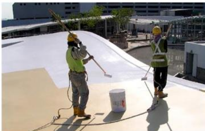
Figura 7: Aplicação de membrana acrílica
