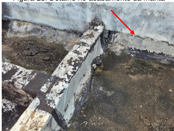
Figura 23: Detalhe no acabamento da manta
