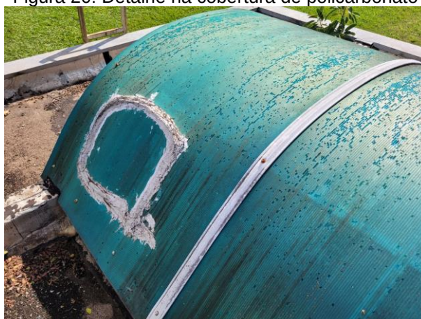
Figura 20: Detalhe na cobertura de polycarbonato
