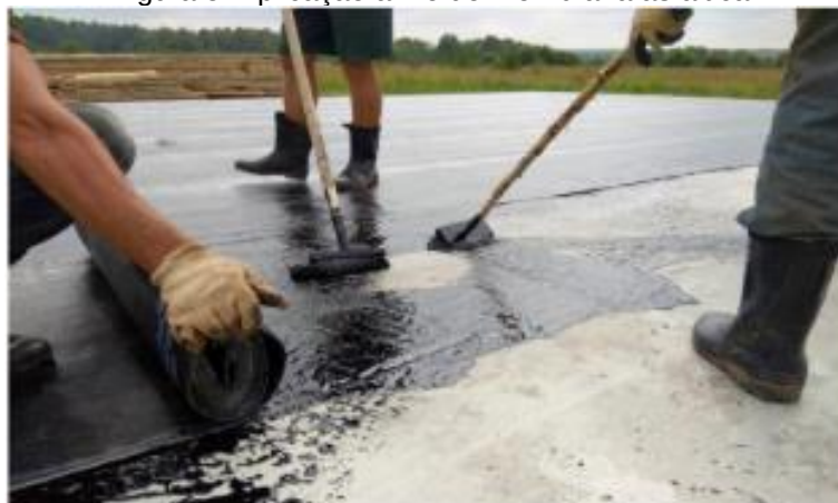
Figura 5: Aplicação a frio de membrana asfáltica
