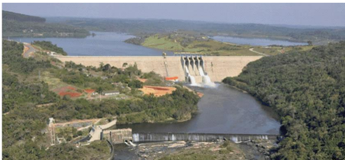
Figura 3 - Foto da Usina Hidrelétrica de Mauá
