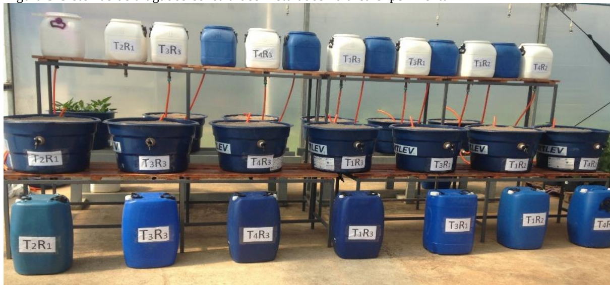
Figura 3-Sistemas de alagados construídos instalados na área experimental
