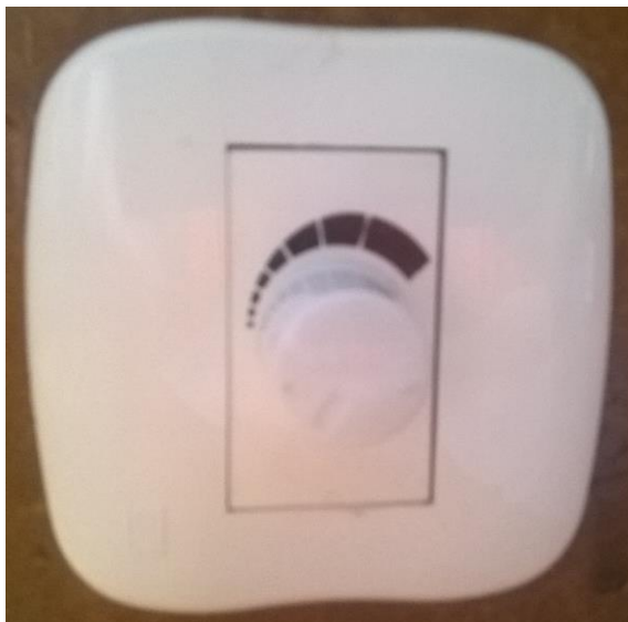
Figura 77: Dimmer. Fonte: A autora.
