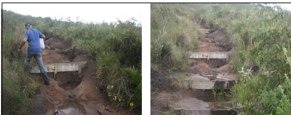
Figura 25 - Tábuas colocadas na trilha para contenção da erosão: área com declive acentuado, propícia a alagamentos.
