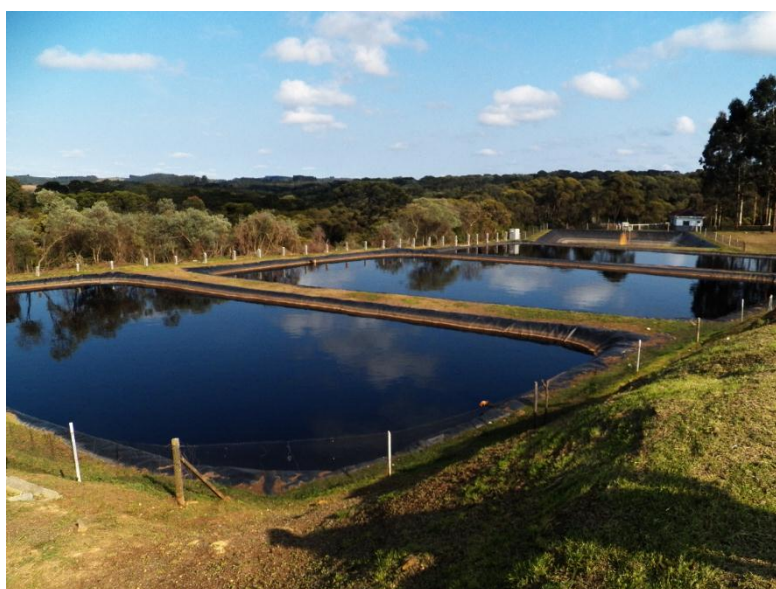
IMAGEM 6: Aterro Sanitário Serrana Engenharia Ltda. Lagoas de chorume. Captação feita pelo autor.
