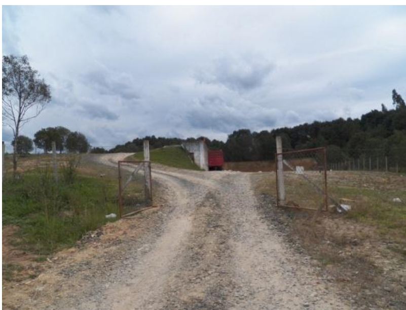
IMAGEM 1: Estação de Transbordo de Rio Azul, vista frontal. Captação feita pelo autor.
