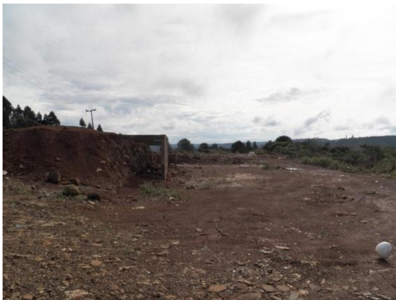
IMAGEM 11: Aterro Controlado Inácio Martins. Visão estação de transbordo em construção em 2015. Captação feita pelo autor.
