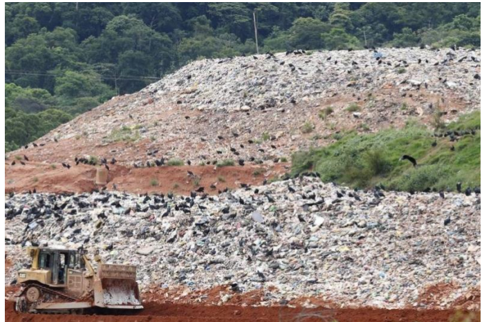
Descaso. Centro de Tratamento de Resíduos de Angra, que opera com licença vencida: chorume, segundo vizinhos, cai em riacho que deságua em uma praia da região. Para piorar, antigo lixão, que fica em frente, continua funcionando - Pablo Jacob / Agência O Globo. Fonte: O Globo. Municípios acumulam dívidas com aterros sanitários, e número de lixões sobe de 17 para 29 Política Nacional de Resíduos Sólidos previa erradicação dos aterros irregulares até 2014. Fonte: O Globo, em 27 mar. 2017.
