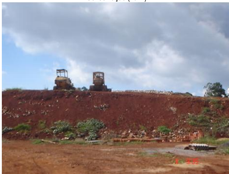
IMAGEM 14: Aterro Sanitário Pema. Célula de Destinação Final. Fonte: Pema Limpeza e Conservação (2017).
