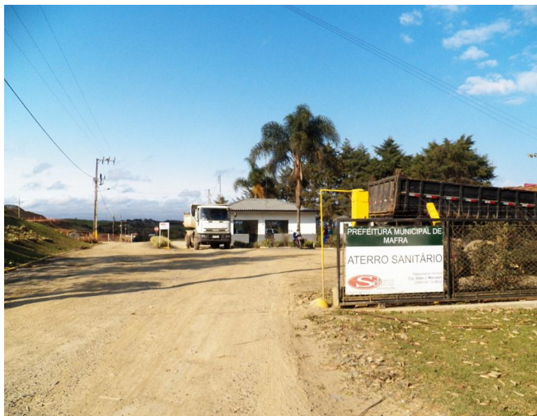
IMAGEM 3: Aterro Sanitário Serrana Engenharia Ltda. Vista acesso principal. Captação feita pelo autor.
