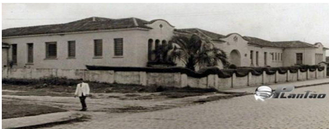
FIGURA 5 – SEDE DO ANTIGO HOSPITAL PSIQUIÁTRICO FRANCO DA ROCHA – Ponta Grossa/PR.
