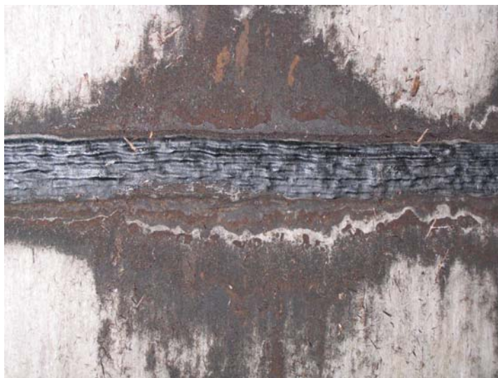
Figura 4.60 Cordão de solda do E7018, utilizado no digestor VI, da Iguaçu Celulose, Papel S.A, de aço ASTM A 516 Grau 60, durante manutenção anual.
