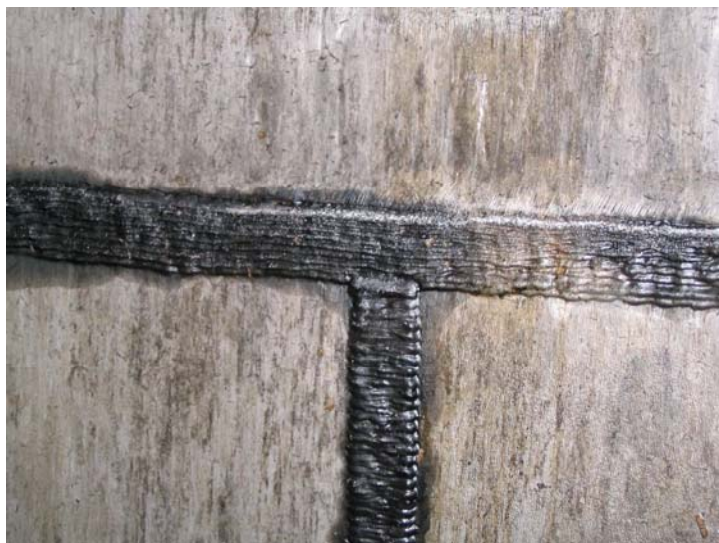
Figura 4.61 Cordão de solda da parede interna do digestor VI, aço ASTM A 516 Grau 60, preenchido com eletrodo AWS E 7018 durante manutenção anual.
