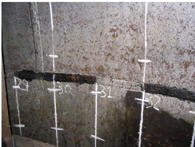
Figura 4.59 Mostra a divisão de 9" X 9" da parede interna do digestor.
