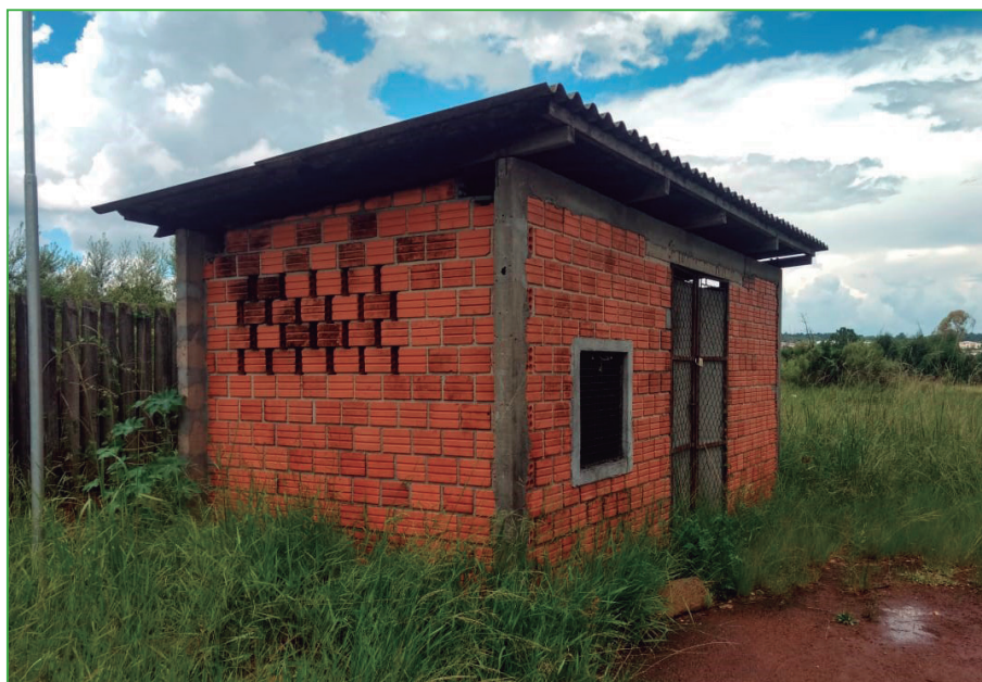
Figura 11 – Abrigo de Resíduos Biológicos – Odontologia
