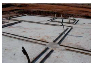
Figura 4 – Colocação das cantoneiras Fonte: Os autores (2009)
