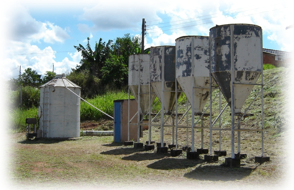
Figura 22: Laboratório de Ensaio em Secagem e Armazenamento (LESA)
